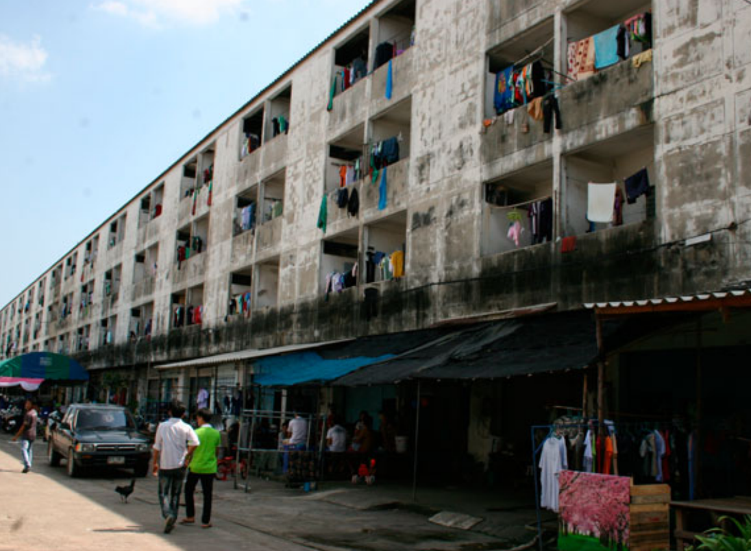
Tonnikalatehtaissa työskentelevien työntekijöiden asuintalo Thaimaassa. Useiden Finnwatchin tutkimien tehtaiden työntekijät muun muassa Malesiassa, Thaimaassa ja Intiassa pyrkivät säästämään rahaa jakamalla vuokraamansa pienen asuinhuoneen 3–5 työntekijän kesken.
