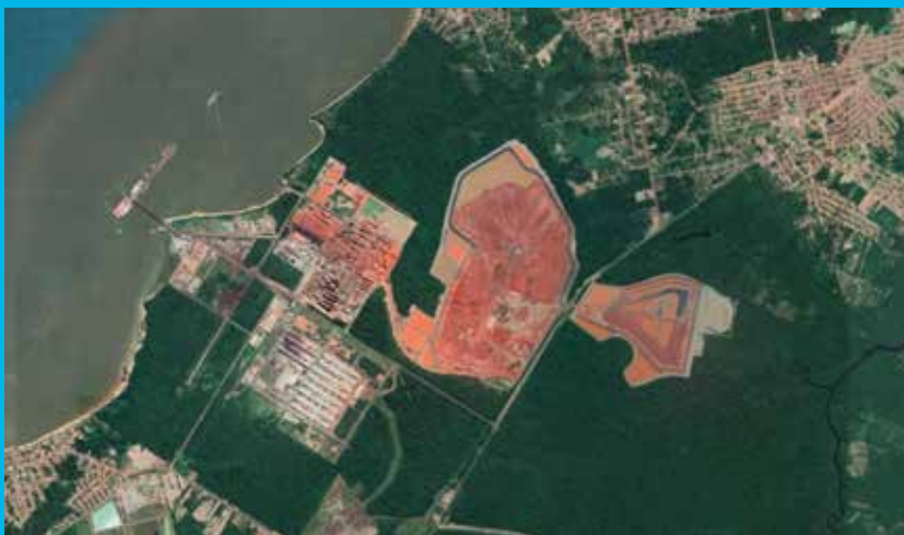
Ylemmässä kuvassa Alunorte vuonna 2010 ennen DRS 2 -altaan rakentamista, alemmassa kuvassa alue vuoden 2018 jälkeen. Jätealtain rakentaminen on entistään lisännyt metsäkatoa alueella.
