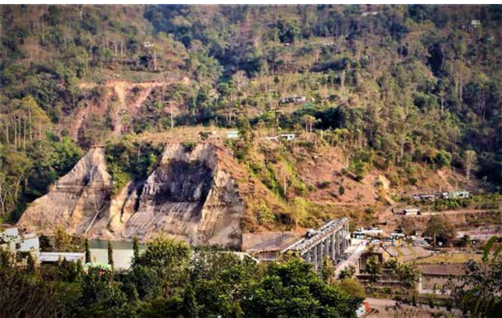
Patoaltaan penkat ovat paikoin sortuneet.
